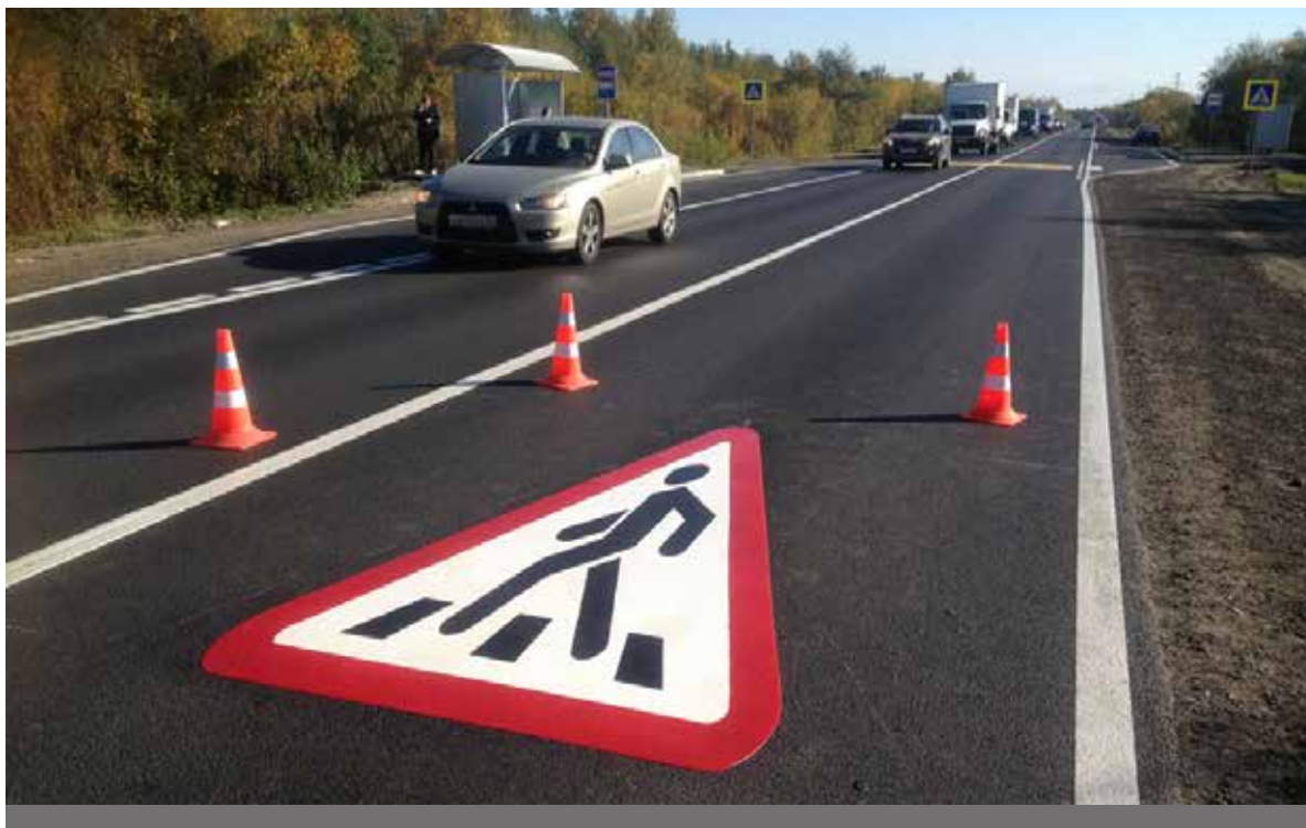
Дорога построена, разметка нанесена.
