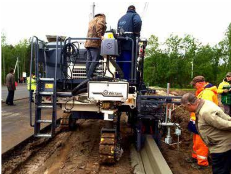
Рабочий процесс - установка монолитного бортового камня.
